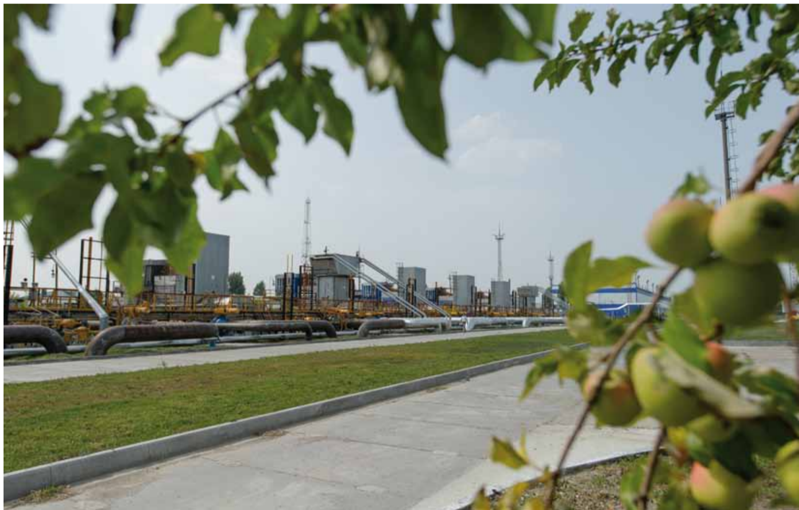
Во II квартале 2013 года Балашовским ЛПУМГ сэкономлено 2687,518 тыс. куб. м. «голубого топлива» за счет уменьшения времени на стравливание газа при выводе линейной части магистральных газопроводов в капитальный ремонт. Кроме того, в числе мероприятий, проводимых коллективом Балашовского ЛПУМГ в рамках Года экологии, – регулярные вертолетные обследования газовой трассы с целью своевременного выявления утечек; изготовление и вывешивание скворечников; беседы со школьниками п. Первомайский на экологические темы; озеленение прилегающих к филиалу территорий, для чего планируется закупить около 300 саженцев березы, дубы, сосны.
