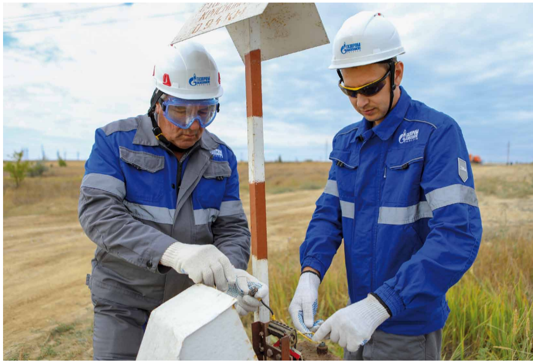
Специалисты Инженерно-технического центра готовят оборудование к обследованию
