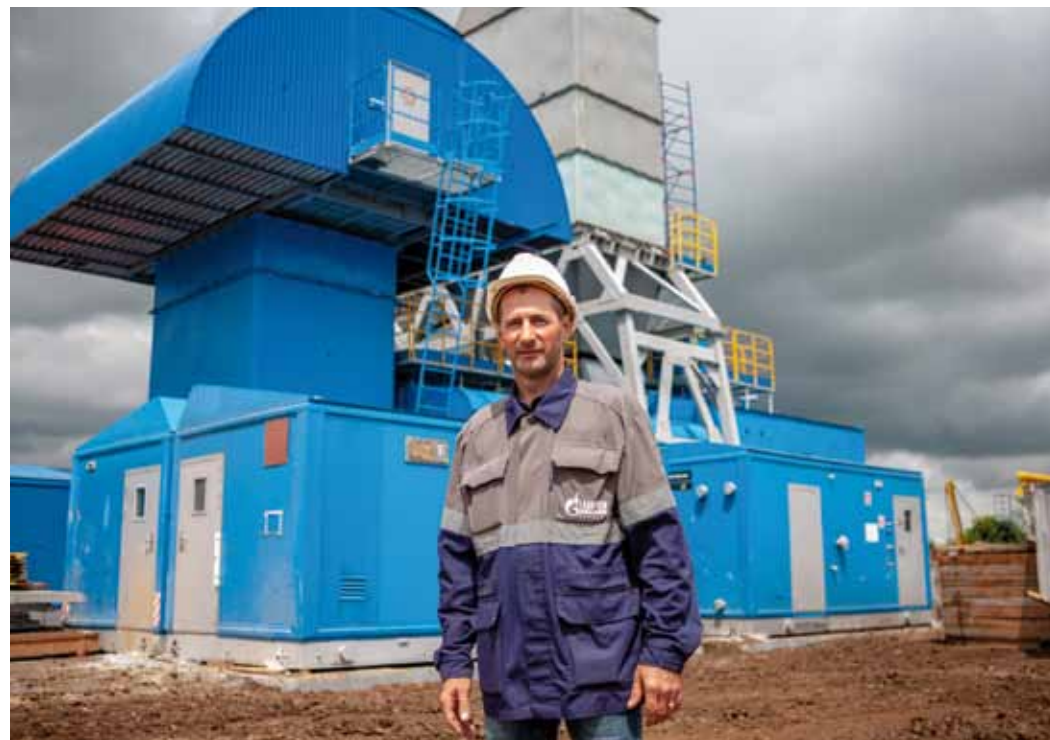
Роман Егоров на строительной площадке компрессорного цеха №2
