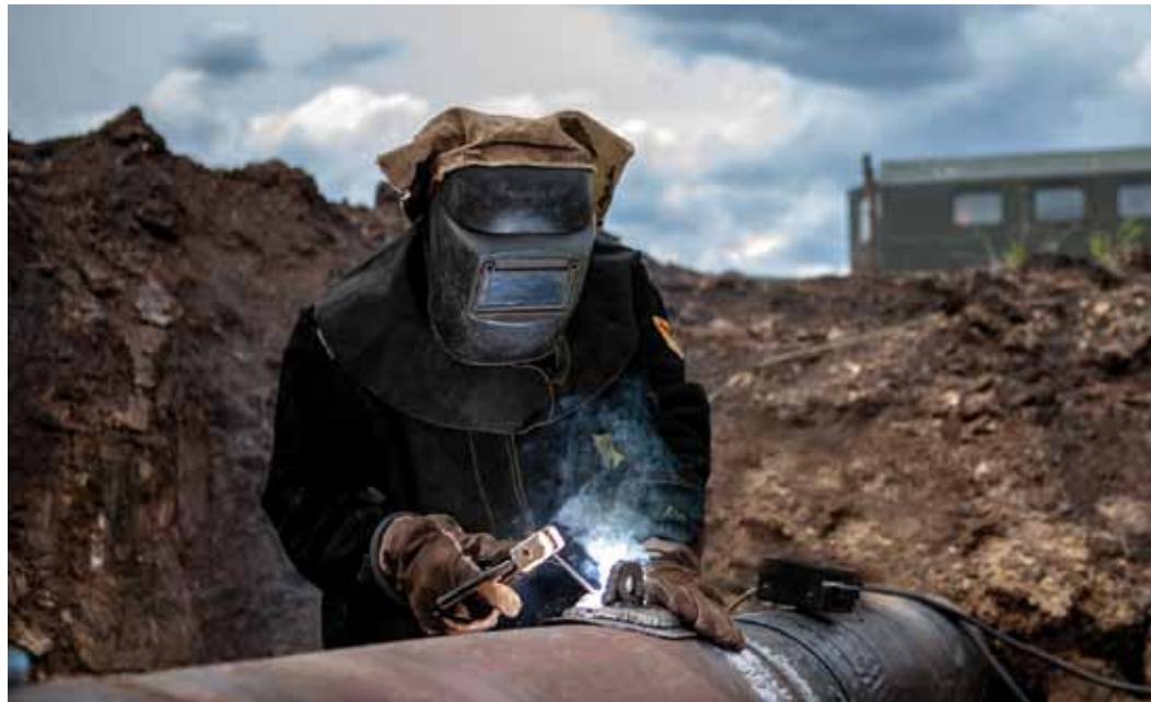
Огневые работы по монтажу временной камеры на 127-м километре газопровода-отвода Саратов-Вольск
