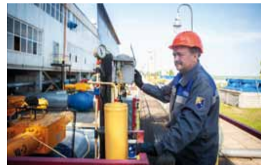
Перестановка 1-го и 2-го кранов турбоагрегата №7
