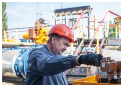
Перестановка 4-го крана турбоагрегата №7
