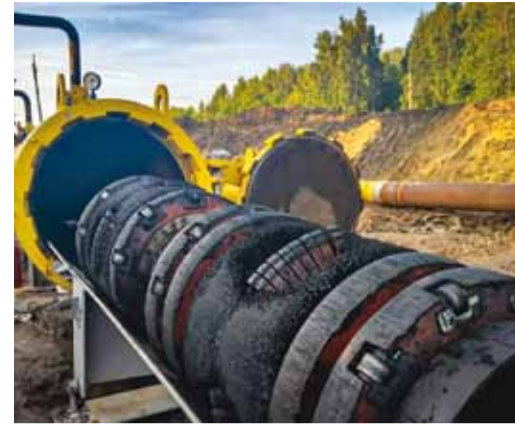
Прием снаряда в Петровском ЛПУМГ
