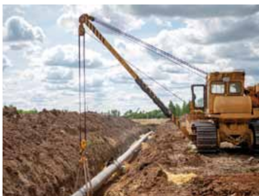
Следующим этапом КРТТ станут гидроиспытания
