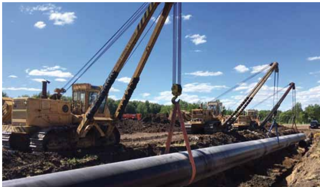
Работы на магистральном газопроводе Уренгой-Петровск-Новопсков
