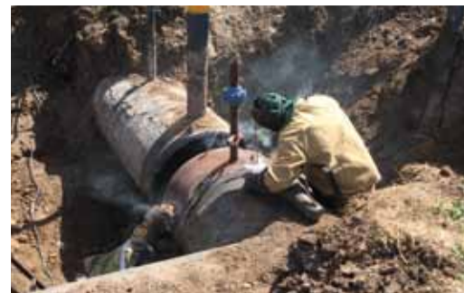
За короткое время был выполнен большой объем работ
