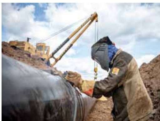
Сварочные работы выполняли две бригады УАВР
