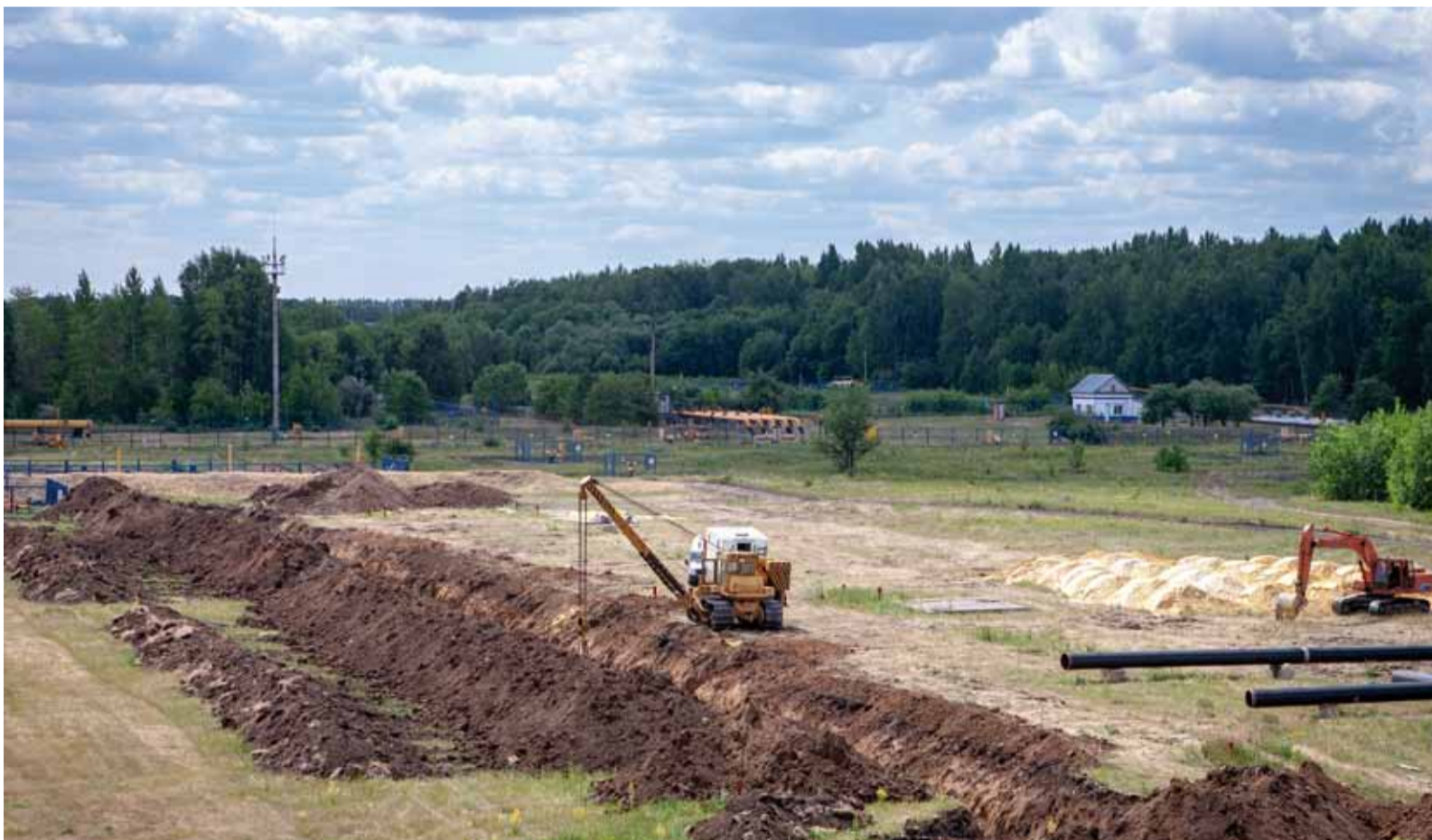
На сегодняшний день новая труба уложена в траншею
