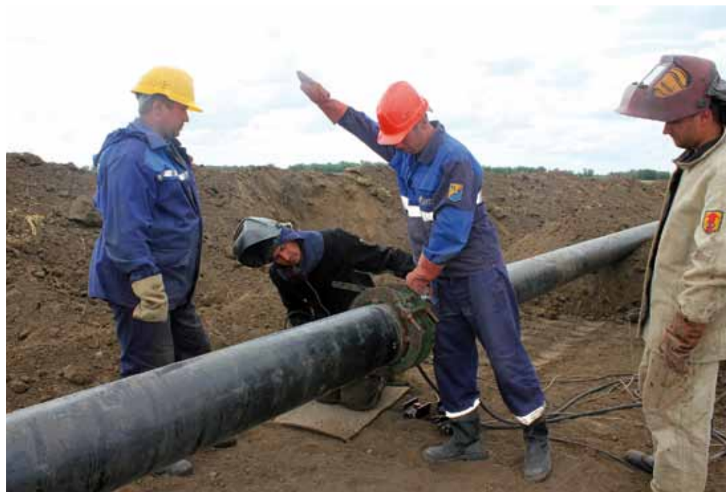
Стыковка труб – дело тонкое.
