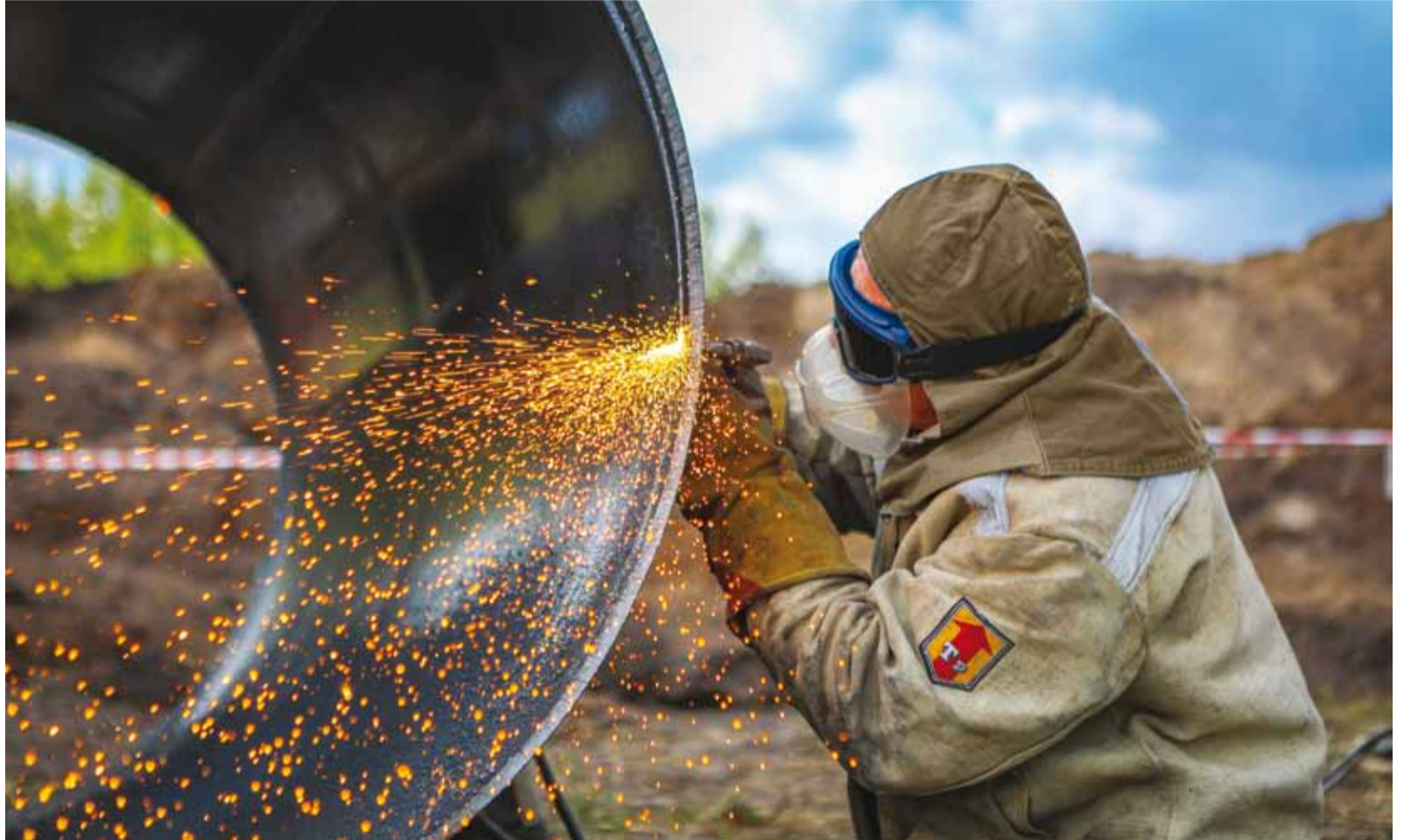
Подготовка «катушки» к монтажу
