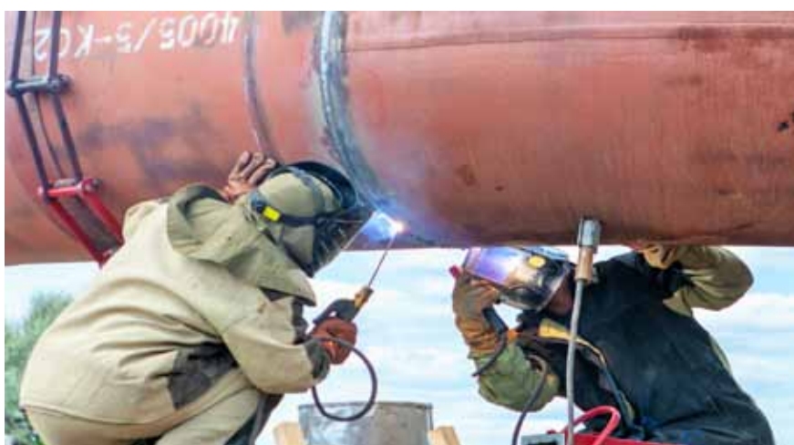
Сварка выходного коллектора ГПА I группы
