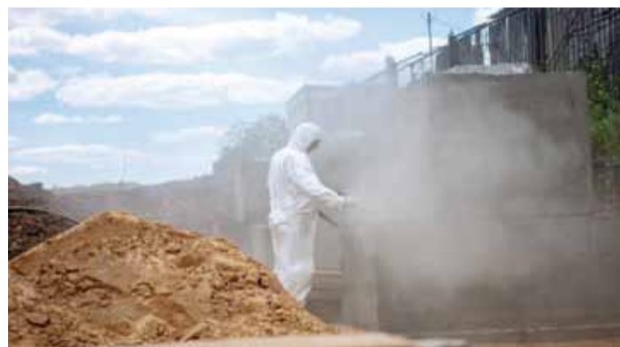
Покрытие фундаментов под эстакаду защитным слоем
