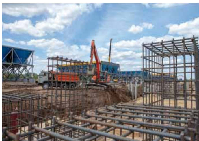
Армирование фундамента под подземный коллектор ГПА I группы
