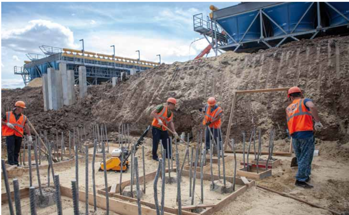
Подготовка к заливке фундаментов коллектора ГПА II группы
