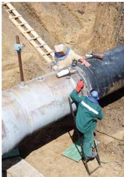
Работы на трассах Сторожевского ЛПУМГ
