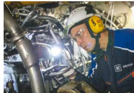
Осмотр двигателя после монтажа
