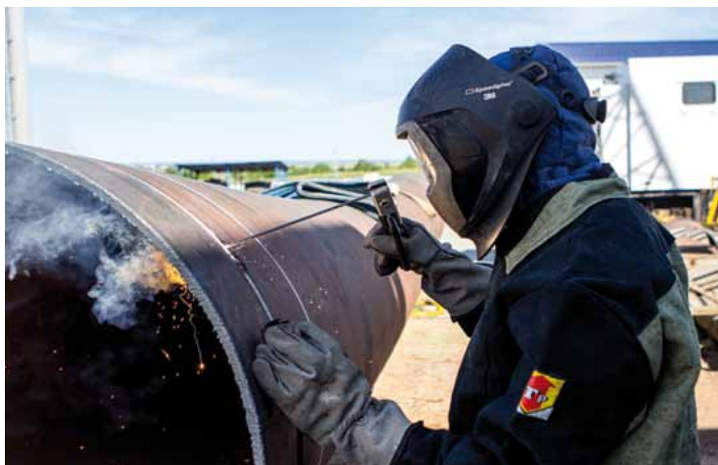
Важный этап входного контроля электродов - сварка контрольного соединения
