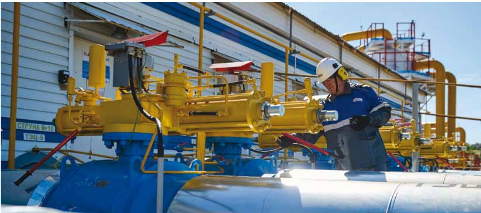
ГРС 2А г. Саратова после технического перевооружения
