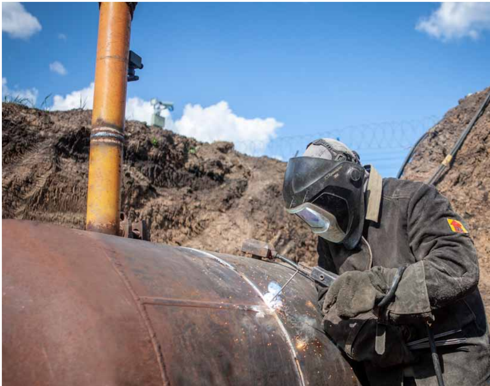
Установка заглушки для отсечения ремонтируемого участка магистрального газопровода САЦ-2.
