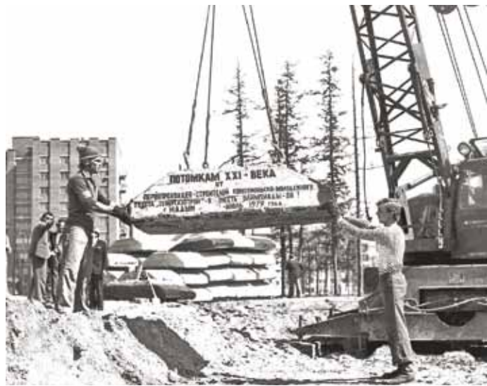
Строительство спортивного комплекса «Молодость». Надым, 1979 год
