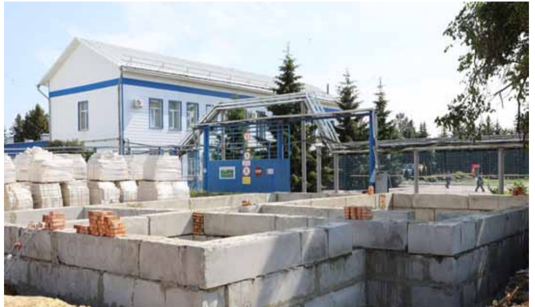
Строительство нового КПП в Петровском ЛПУМГ
