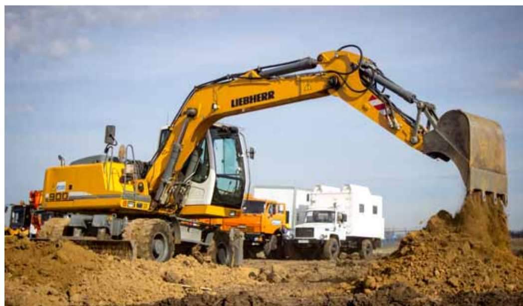
Начало земляных работ
