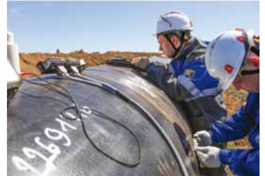
Контроль качества сварного соединения
