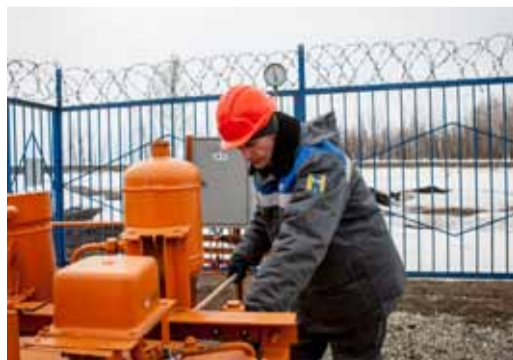
Перестановка линейного крана с помощью гидравлического привода
