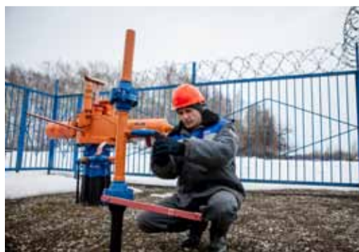
Установка заглушек на открытых концах кранов КШ-15 стойка отбора импульсного газа
