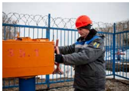
Перестановка байпаса линейного крана с помощью штурвального привода
