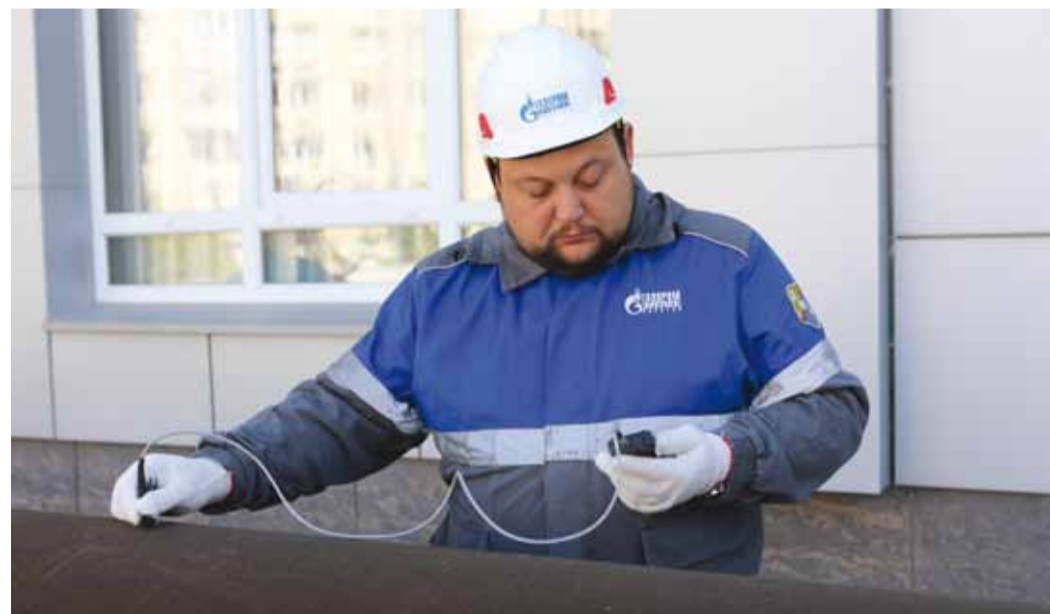
Оценка состояния трубы
