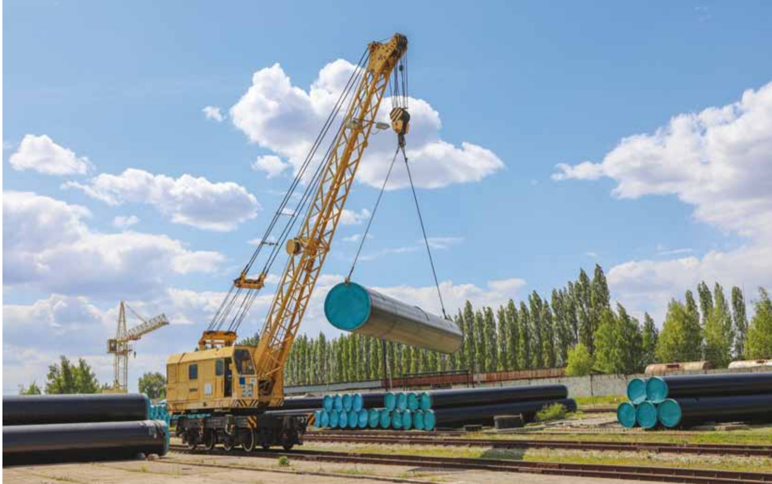
Железнодорожный кран перемещает трубу для отправки на объект
