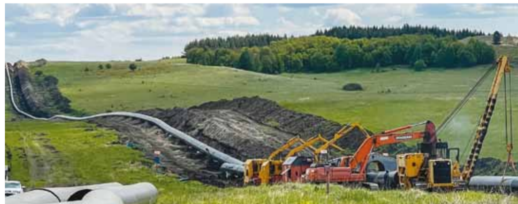
Капремонт газопровода САЦ-2
