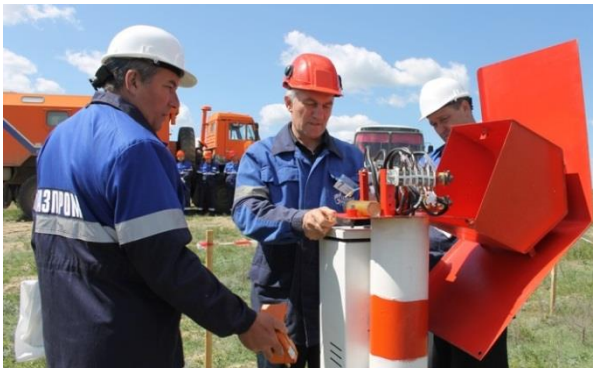
Проведение выездных занятий по программе повышения квалификации по профессии «Монтер по защите подземных трубопроводов от коррозии»
