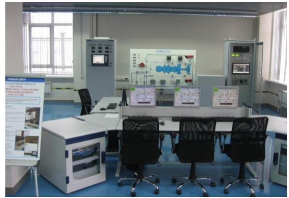
Система автоматического управления газоперекачивающими агрегатами
