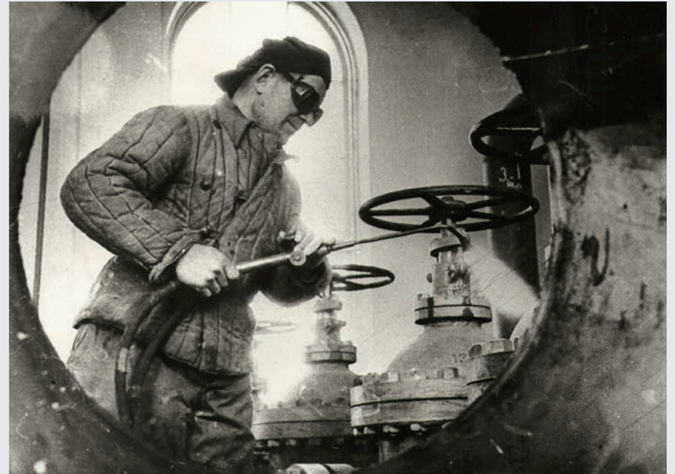
Сварочные работы в компрессорном цехе. 1944 г.
