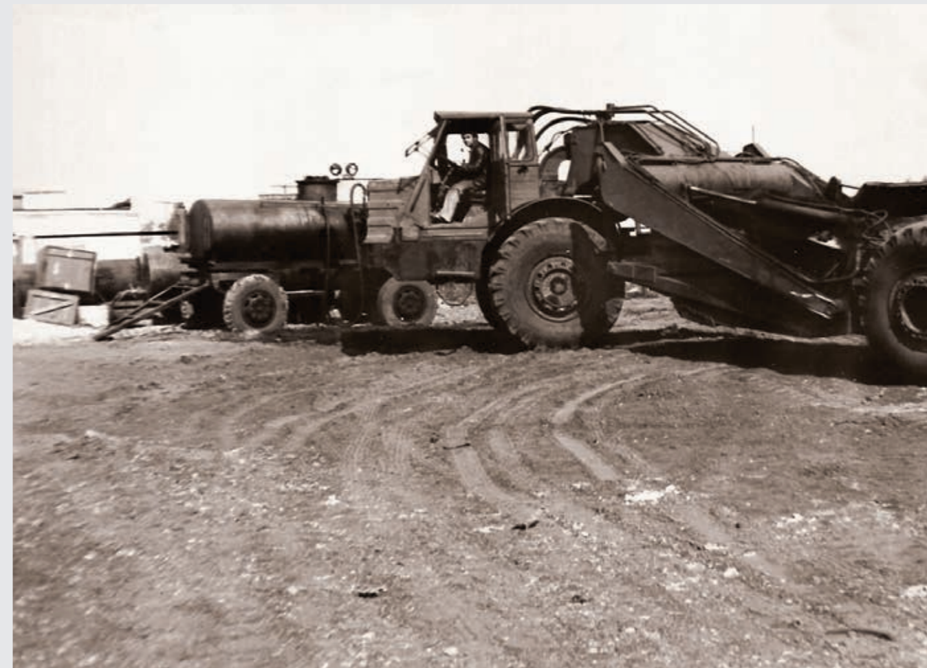
Подготовка техники к ремонтным работам. Начало 1990-х годов
