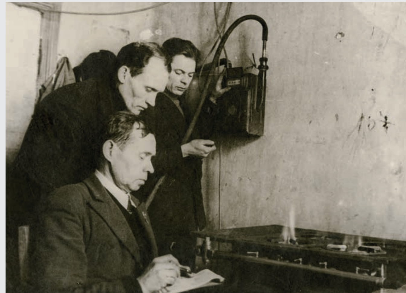
Проверка газового оборудования в жилом доме. Саратовская область. 1946 г.
