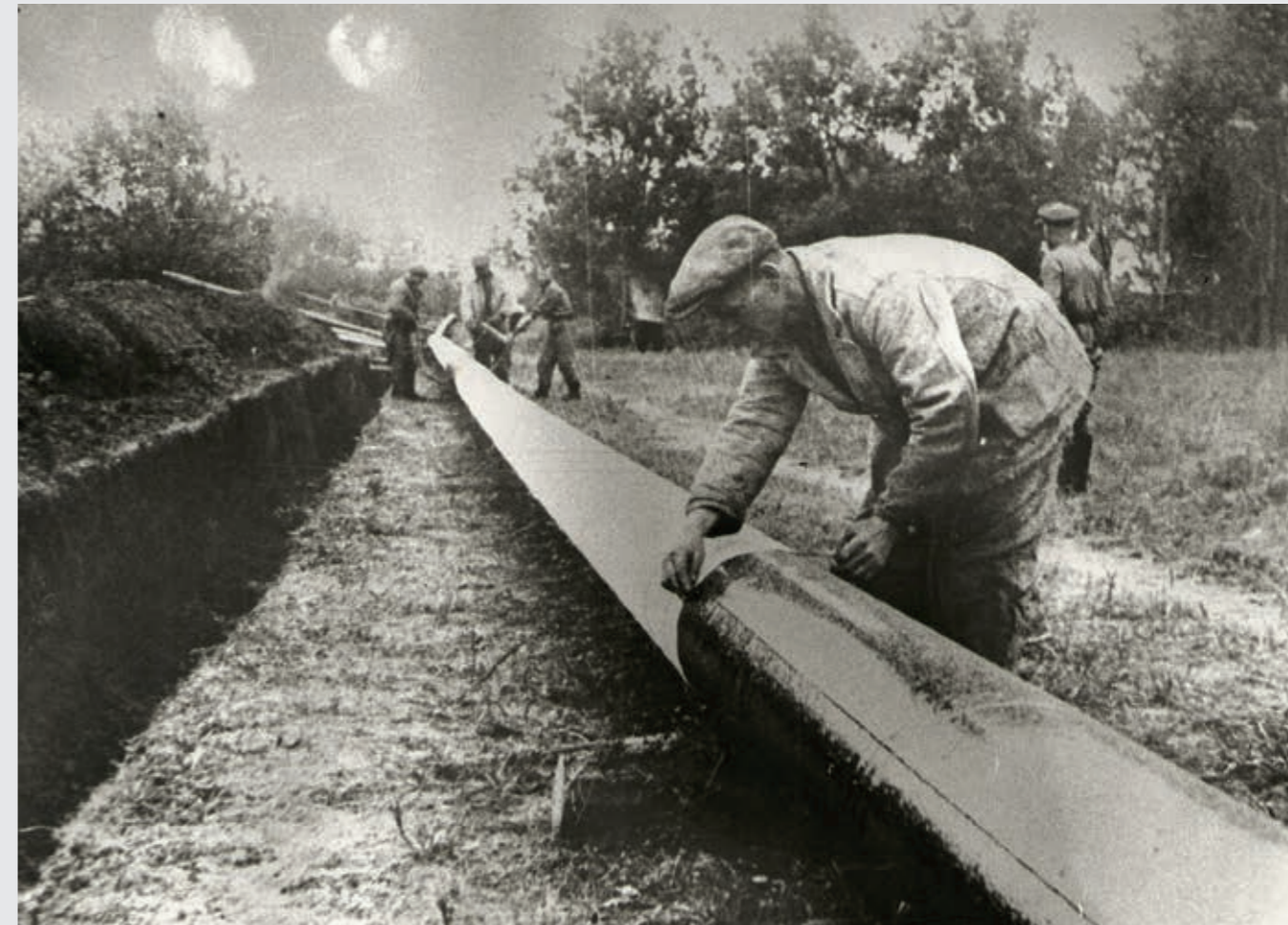
Газопровод Саратов – Москва. Стыковка труб и подготовка их к сварке. 1945 г.
