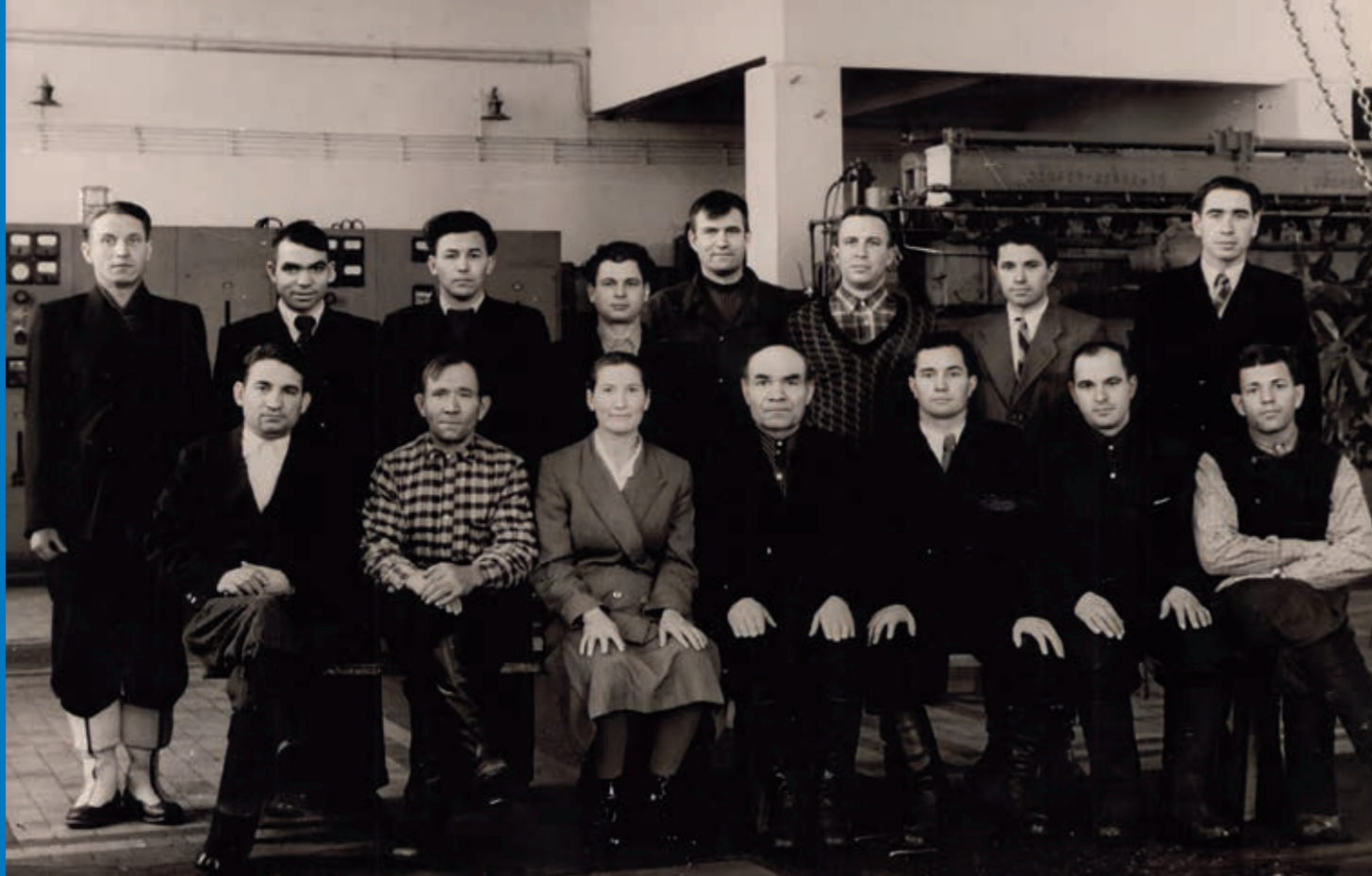
Зимина Анна Васильевна (3-я слева). Здание электростанции ЭВС. 1960-е годы
