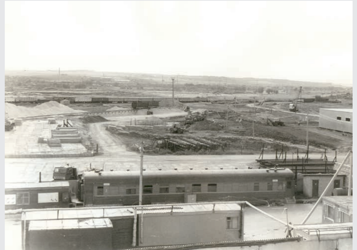
Строительство УМТС и К. 1980-е годы
