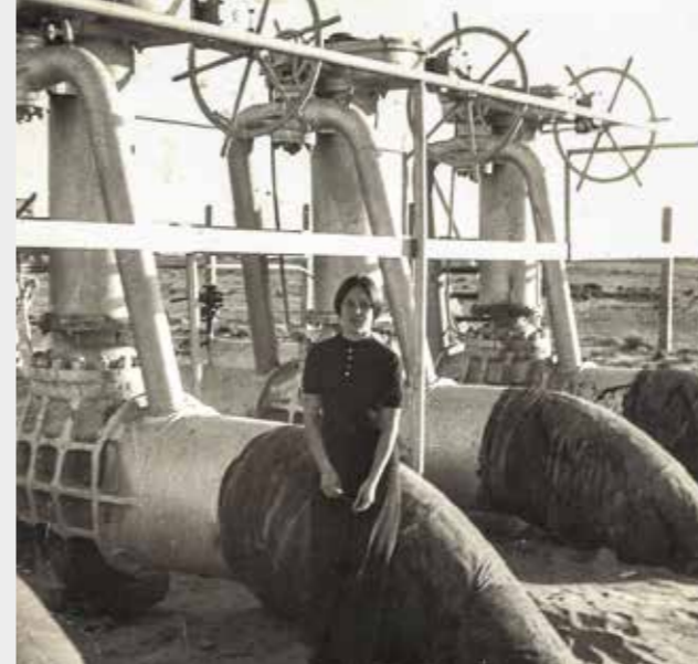
Дворянкина (Гаршина) Валентина Александровна. Замерный узел. Компрессорная станция в Бейнеу. 1976 г.
