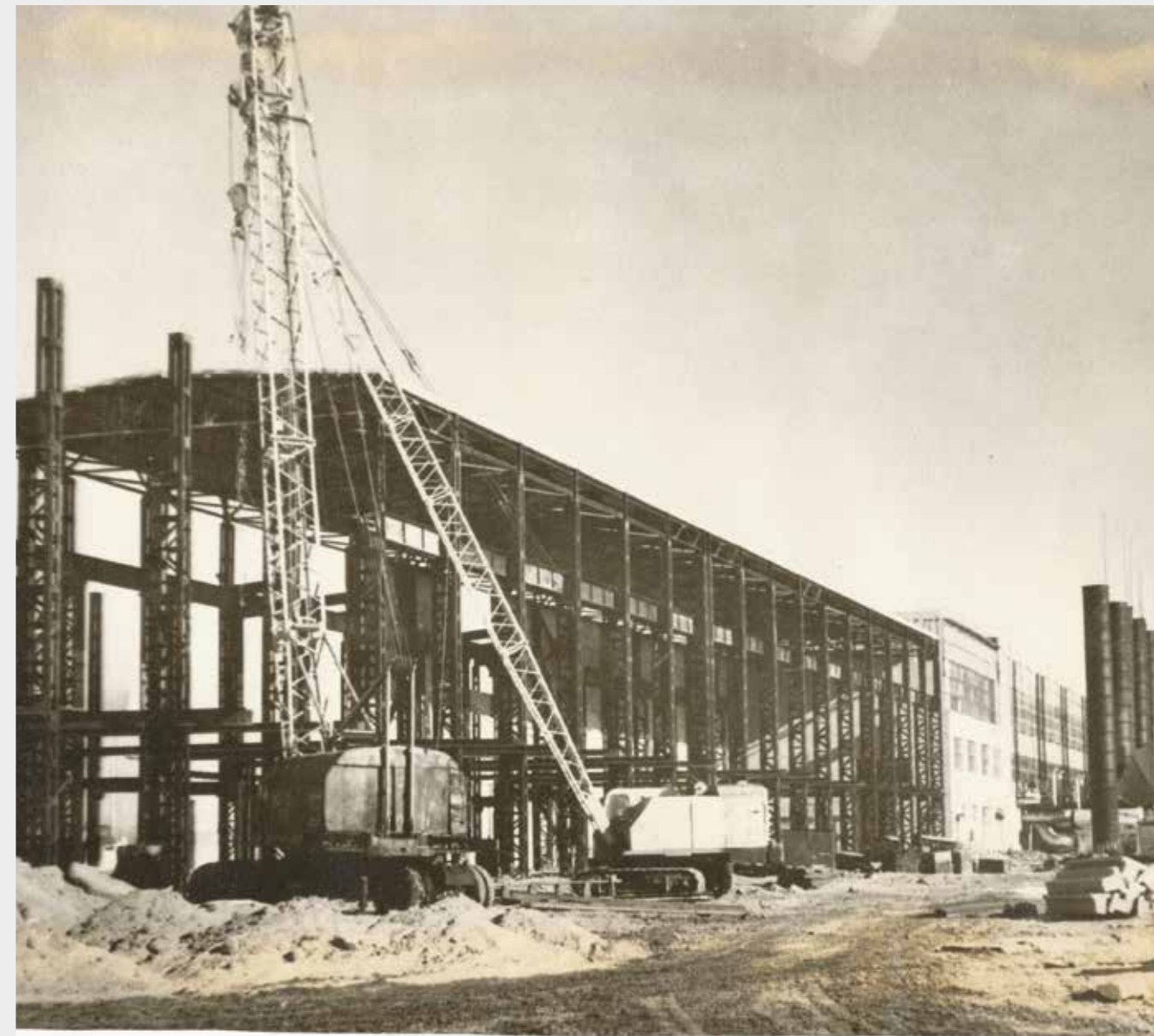
Строительство Индерборгского ЛПУМГ. Середина 1960-х годов
