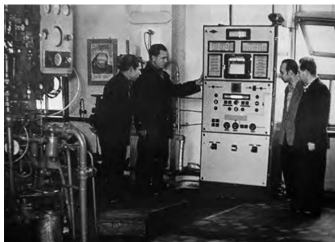
Пневмоэлектрическая система автоматического управления на Кологривовской КС
