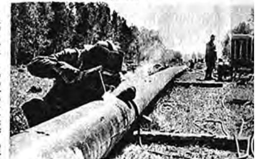
По этим трубам будет проходить газ. Трубы (длиной 12 метров каждая) свариваются при помощи электросварочных аппаратов.
