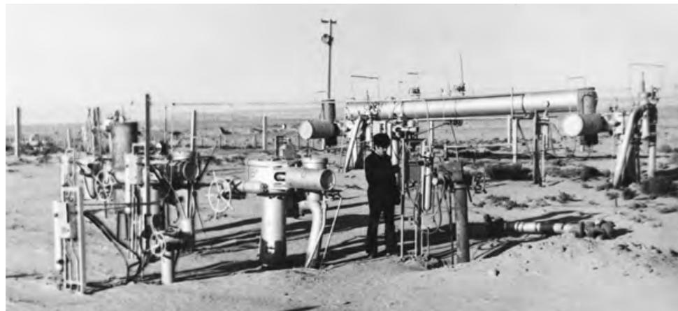
Проверка дистанционного управления кранами на компрессорной станции в Казахстане
