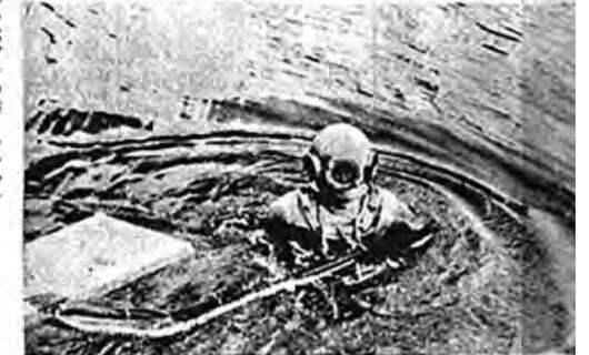
Трасса газопровода проходит через реку Паху. Водолаз — старшина 2-й статьи Н. Грудков спускается под воду для осмотра траншеи, в которую будут уложены трубы.
