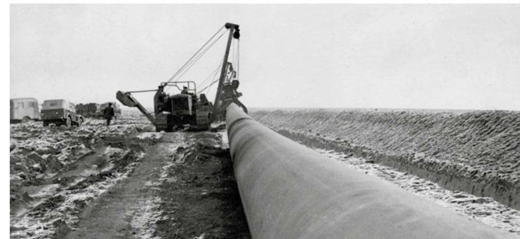
Укладка трубы газопровода САЦ на окраине посёлка Мокроус. 1968
