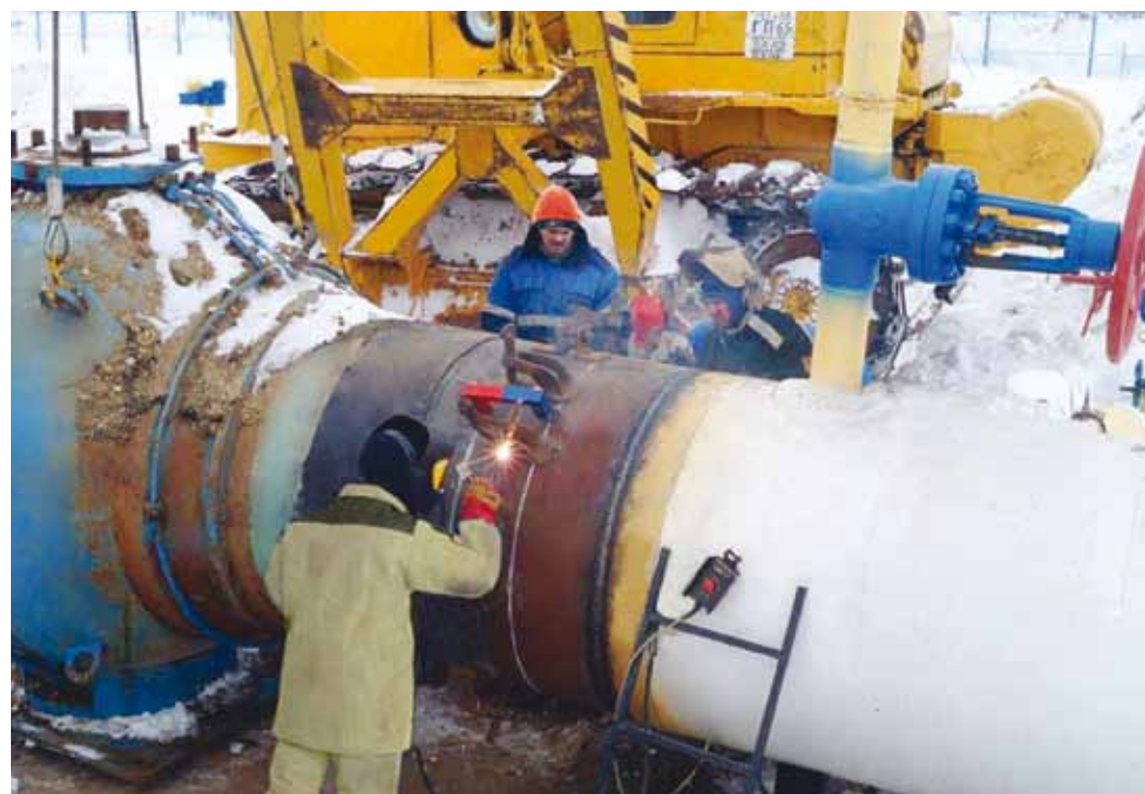
Подготовительные работы перед монтажом крана
