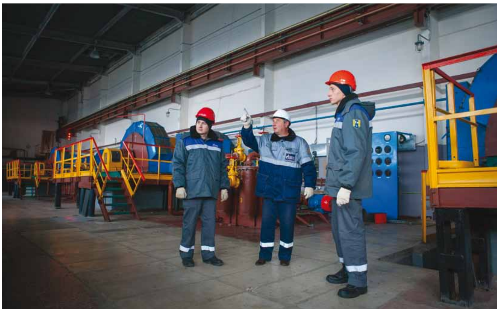
Начальник компрессорной станции № 25 Камо Агалянц (в центре) с работниками осматривает цех до его реконструкции
