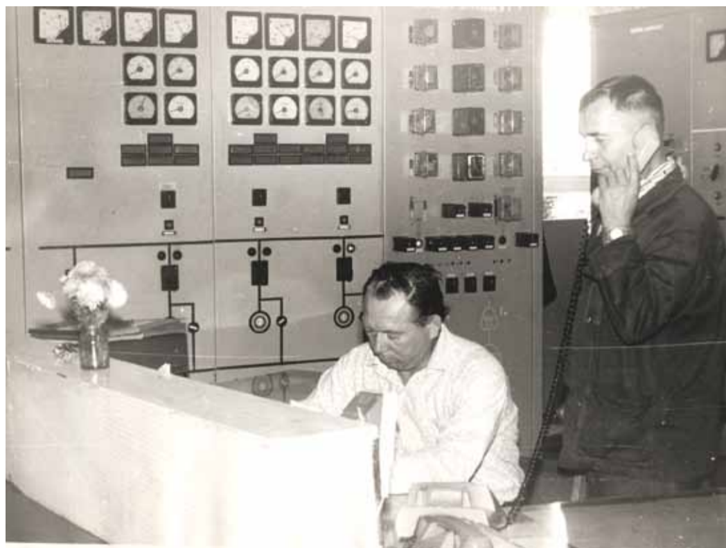
Главный щит управления цеха № 1 Сторожевского ЛПУМГ. Начало 80-х годов
