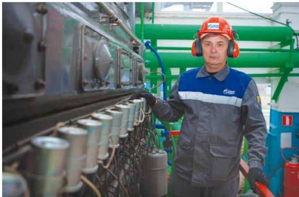
зервная установка на станции была спроектирована еще в 70-х годах. Но если по каким-то причинам произойдет сбой работы и этой линии электропередачи, на сегодняшний день в цехе имеется еще и автоматический дизель-генератор для допол-
