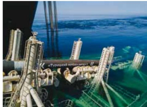
Продолжается строительство газопровода «Турецкий поток». На сегодняшний день суммарно по обеим ниткам уложено 1775 км труб, что составляет 95% от общей протяженности морского участка газопровода. Завершено сооружение объектов берегового примыкания в России в районе г. Анапы, ведутся пусконаладочные работы, которые будут завершены в 2018 году. В Турции вблизи поселка Кыйыкей продолжается строительство приемного терминала. Ввод в эксплуатацию газопровода планируется до конца 2019 года.
