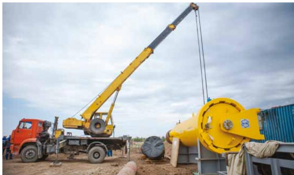
Капитальный ремонт камеры приема – запуска очистных устройств на 1290 километре газопровода САЦ
