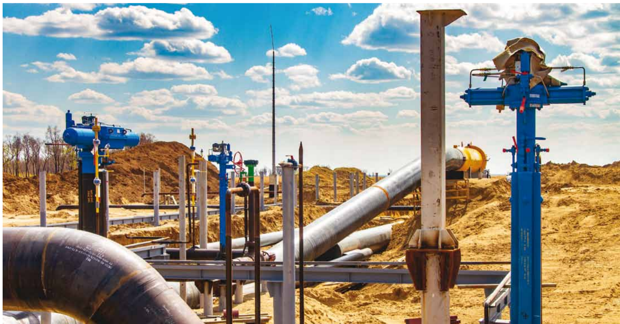
Строительство объектов газопровода «Сила Сибири»
