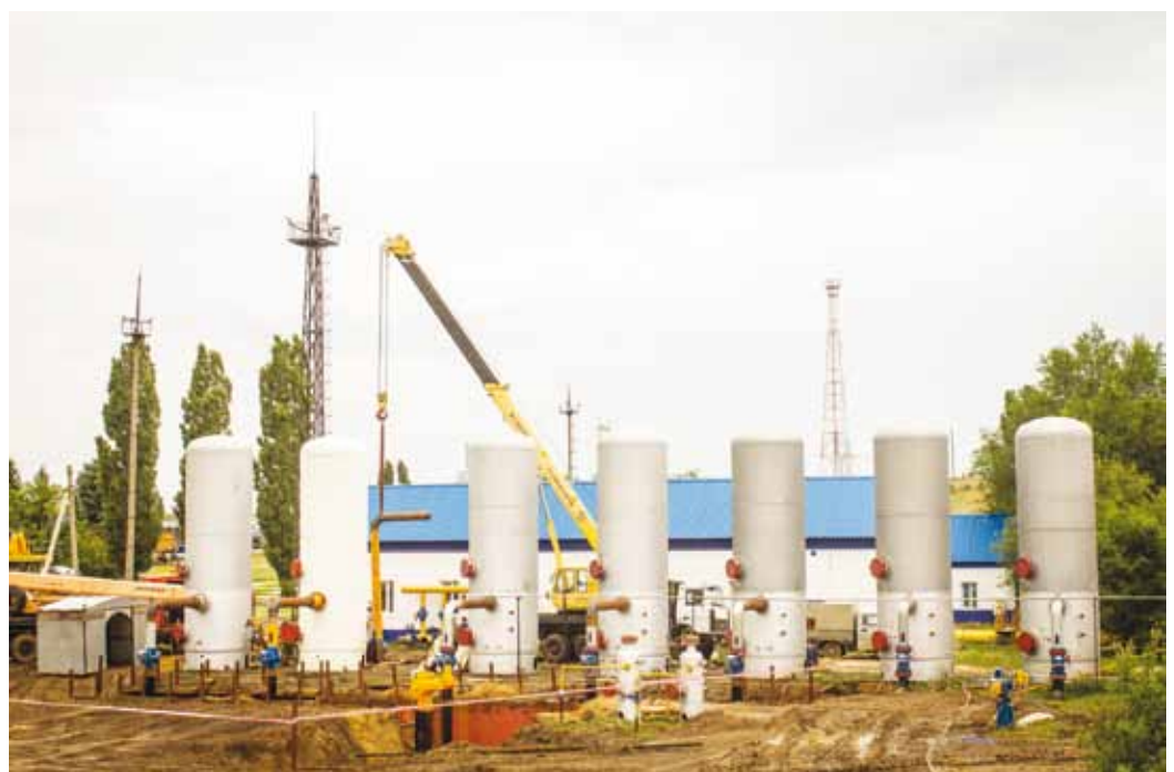
При выполнении технического обслуживания, ремонта и реконструкции объектов газотранспортной системы неукоснительно соблюдаются все нормативные требования
