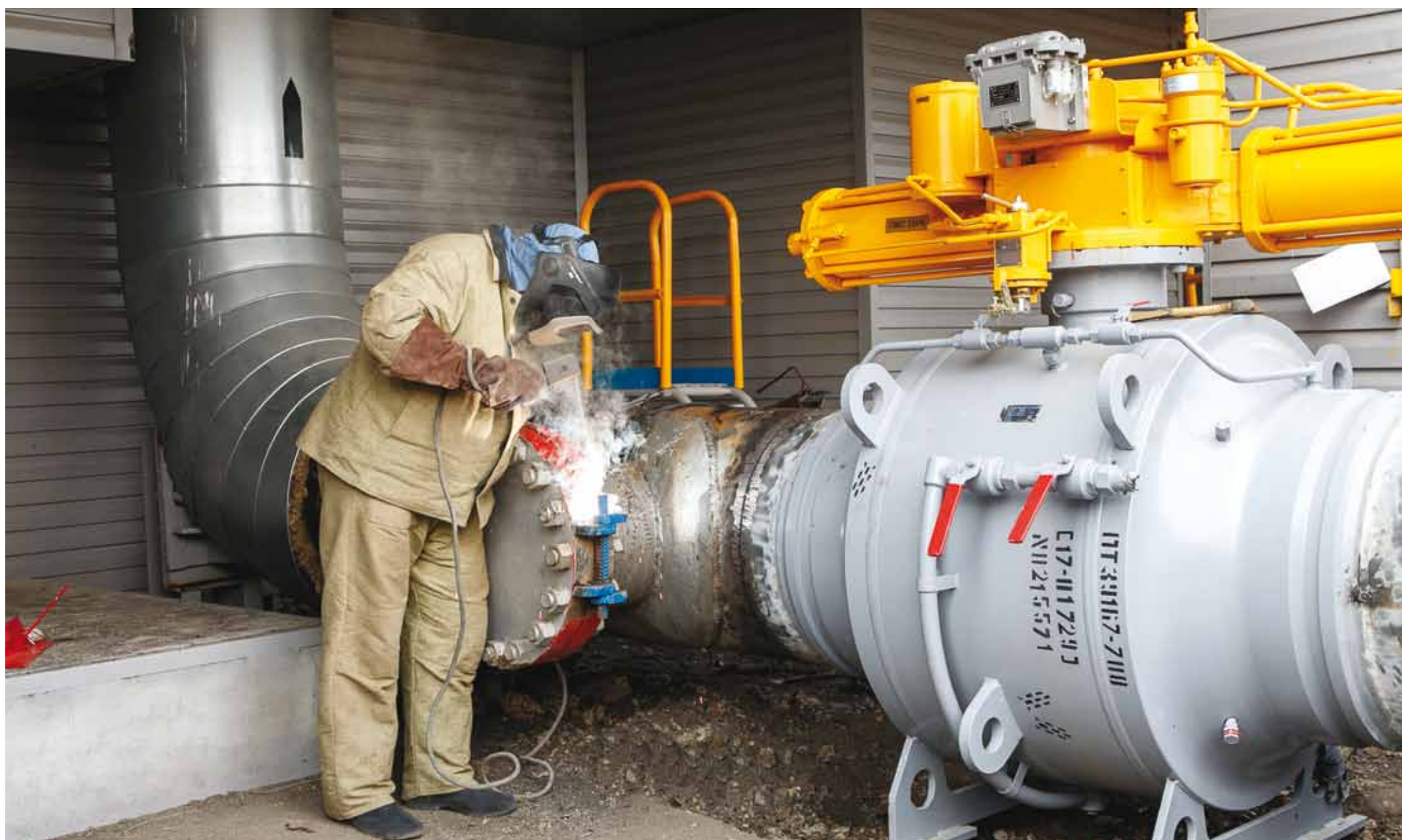
Проводятся сварочно-монтажные работы
