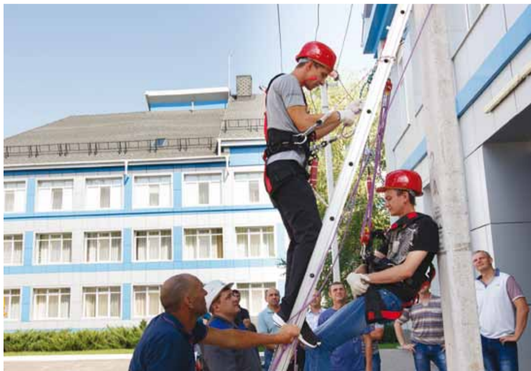
Тема занятия – выполнение работ с применением систем обеспечения безопасных работ на высоте
