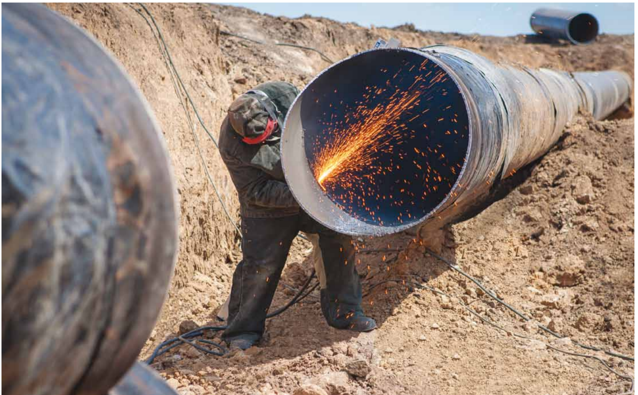
Замена дефектных участков трубы на 40-м километре газопровода «Мокроус – Самара – Тольятти»
