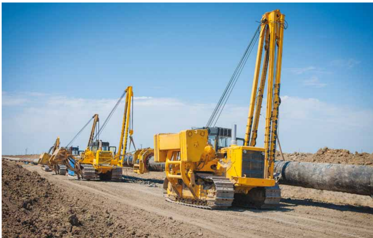
Общество неукоснительно соблюдает нормативные требования при выполнении технического обслуживания, ремонта и реконструкции объектов газотранспортной системы
