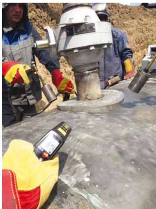
Производится прогрев трубы
