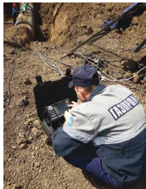
Работы проводятся под строгим контролем специалистов полевой измерительной лаборатории ИТЦ
