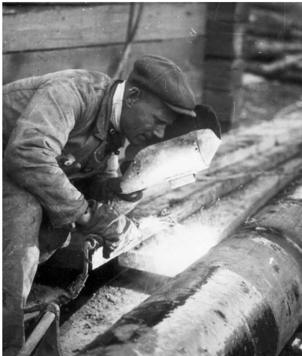
Сварка труб газопровода «Елшанка – Саратовская ГРЭС». 1942 г.
