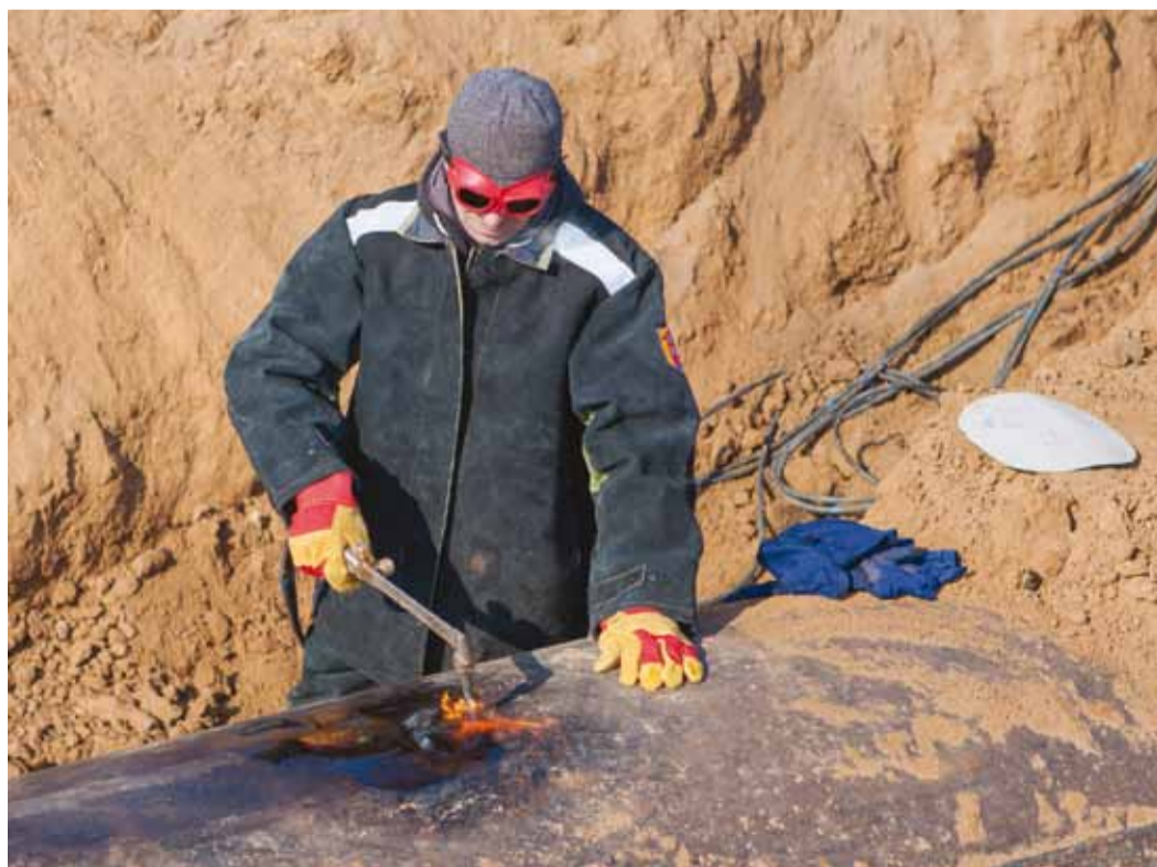
Резчик приступил к вырезке технологического отверстия
