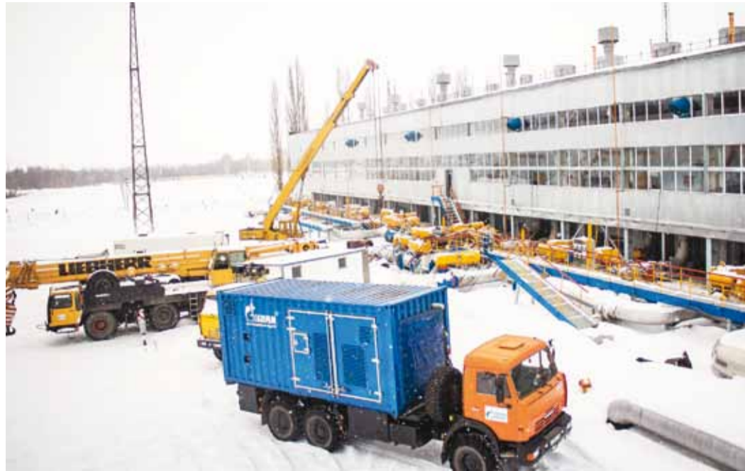
Работы ведутся в хорошем темпе, несмотря на погодные «сюрпризы»
