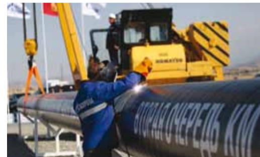
Сварка первого стыка
