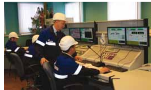
В момент запуска компрессорной станции
