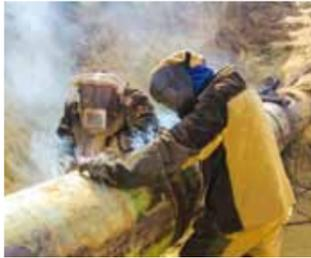
Впервые при проведении ремонтных работ на магистральных газопроводах была применена методика установки сварных стальных муфт, что позволило провести работы, не прекращая транспортировку газа потребителям.
