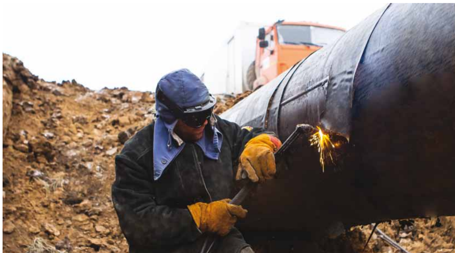
Электрогазосварщик УАВР Артур Хисматулин выполняет демонтаж дефектного участка газопровода
