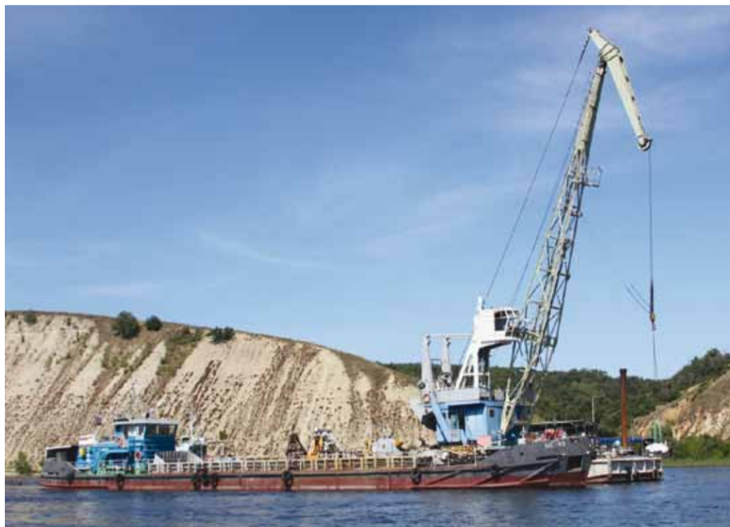
Капремонт подводного перехода газопровода «САЦ-2»
