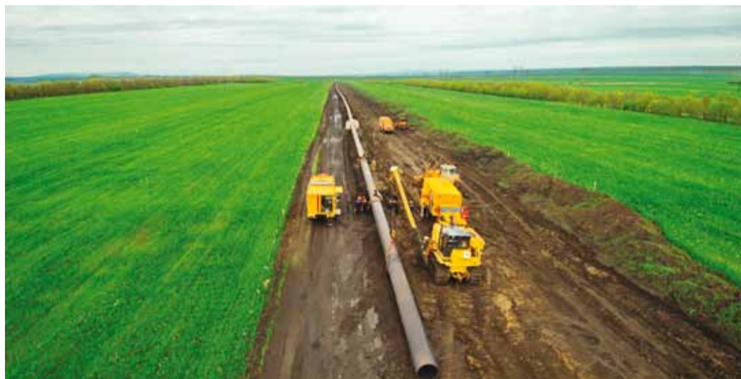
Производственные работы на магистральном газопроводе «Новопсков – Аксай – Моздок»
