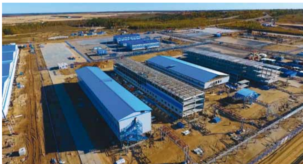
Строительная площадка Амурского газоперерабатывающего завода, сентябрь 2017 года
