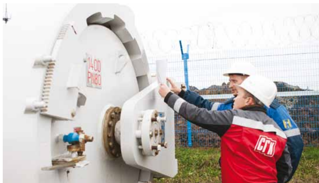
Работы подрядной организации на объекте ведутся под наблюдением специалистов Башмаковского ЛПУМГ и службы строительного контроля ИТЦ
