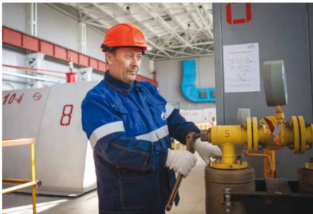
Машинист технологических компрессоров Александр Юрко выполняет переключение фильтров тонкой очистки топливного газа
