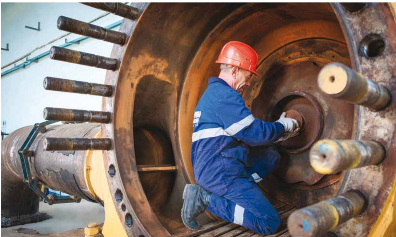
Слесарь по ремонту ТУ КС Виктор Лузановский устанавливает оптекатель на рабочее колесо нагнетателя
