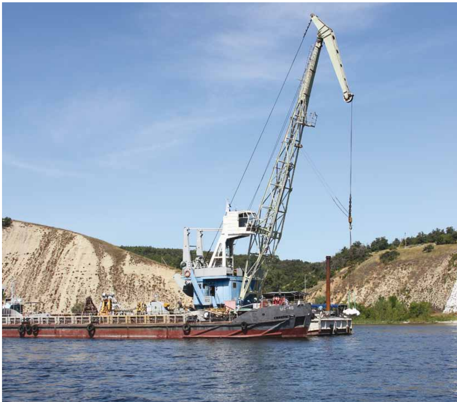
Производится засыпка оголенных участков магистрального газопровода САЦ-2, находящегося в зоне эксплуатационной ответственности Приволжского ЛПУМГ
