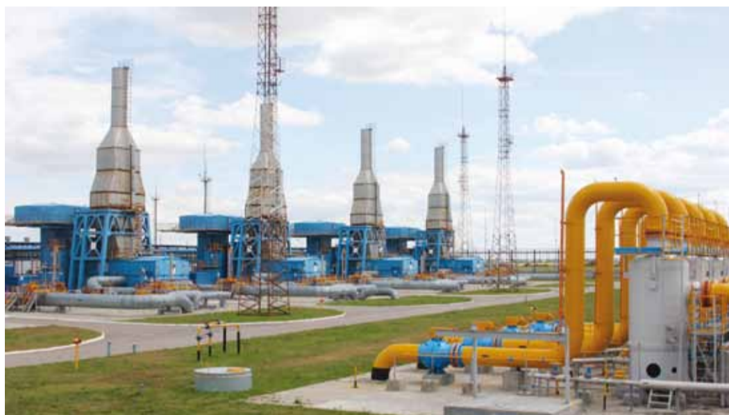
На площадке КС «Новопетровская»
