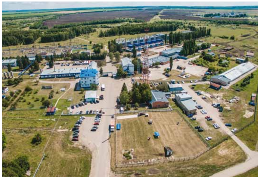
Взгляд из - под облаков: Петровское ЛПУМГ и КС «Новопетровская»
