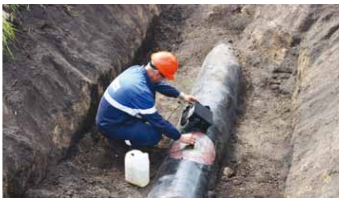
Проведение ультразвукового контроля технологического отверстия
