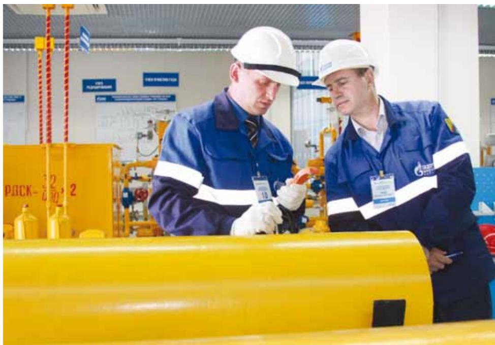
Проводится проверка нанесенных защитных лакокрасочных покрытий
